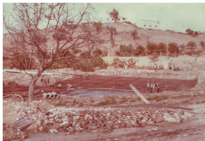
En 1978 construcción de la piscina olímpica.
